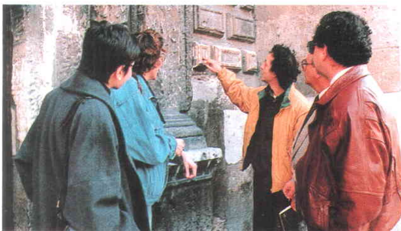
Los técnicos estudian la piedra de la fachada del Palacio Santa Cruz de Valladolid, rehabilitado con fondos europeos.
